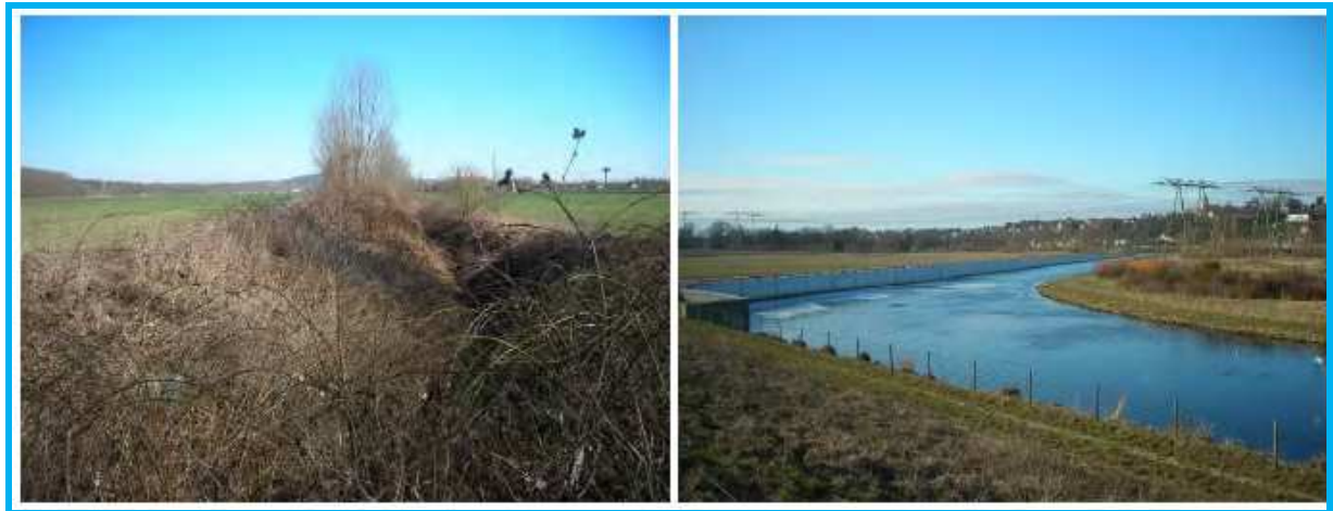
Figure 136 : Ponctuation arbustive sur les drains de la plaine et lignes HT
