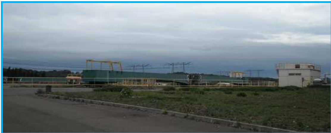
Figure 238 : Photo sur site des épaisseurs
