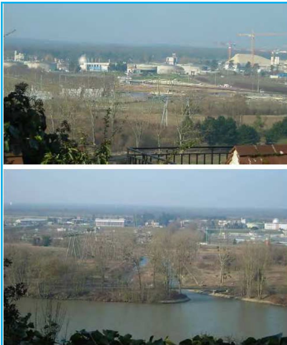
Figure 129 : Vues sur l'usine depuis la Frette sur Seine
