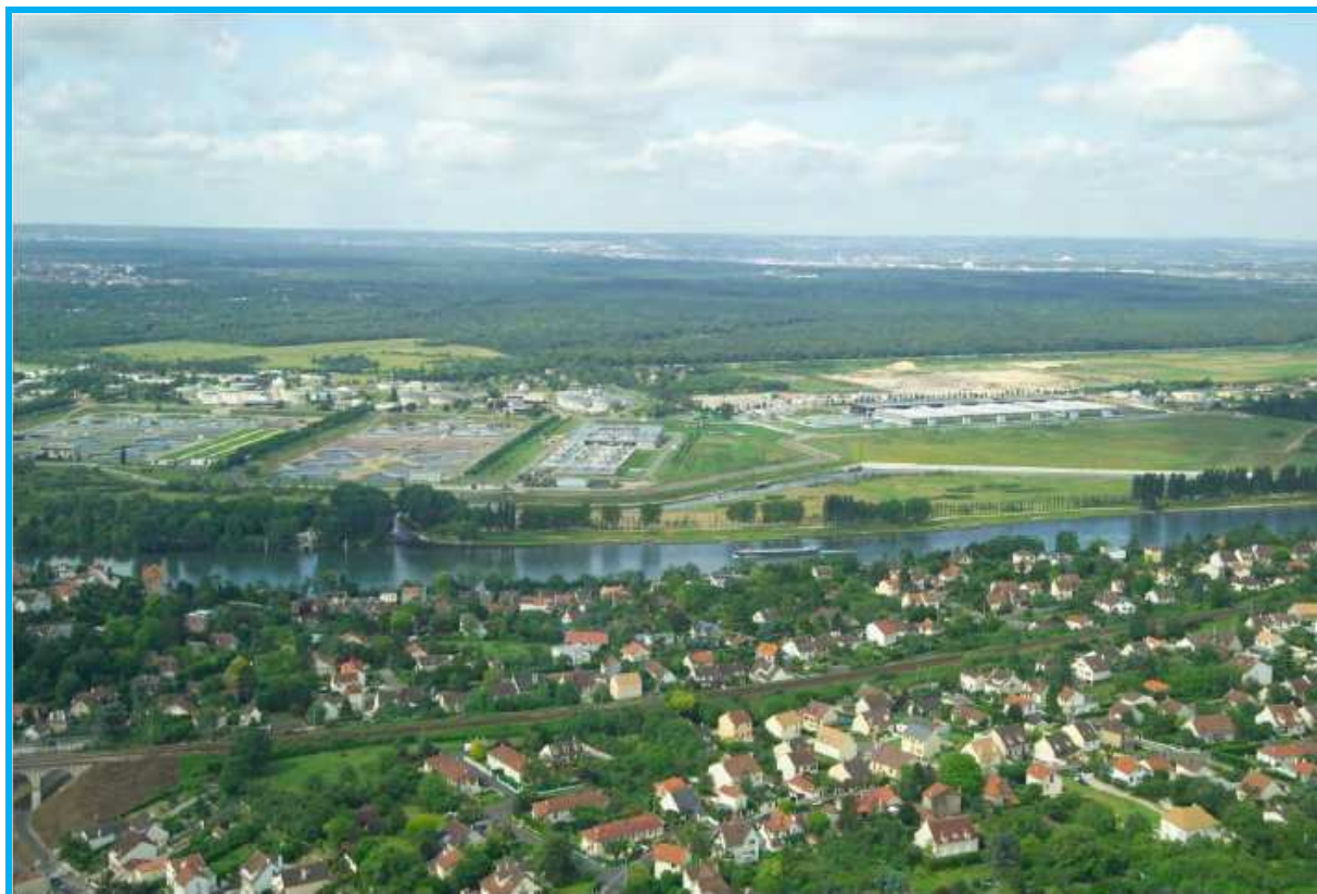
Figure 132 : Vue aérienne de l'usine Seine aval depuis la rive droite.
