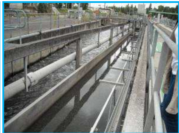
Bassin de reprise
