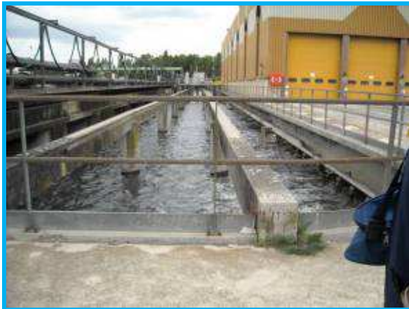
Bassin de banalisation
