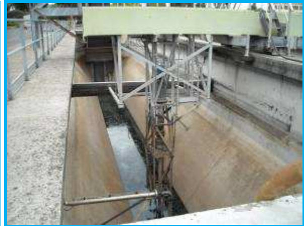
Bassin de dessablage-dégraissage vide
