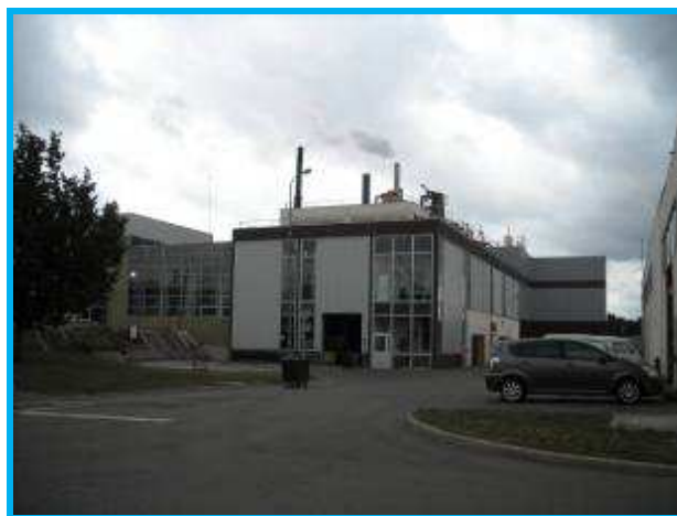
Figure 243 : Photo sur site du bâtiment des fours de l'UPBD
