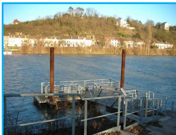
Figure 107 : Bac de traversée de la Seine
