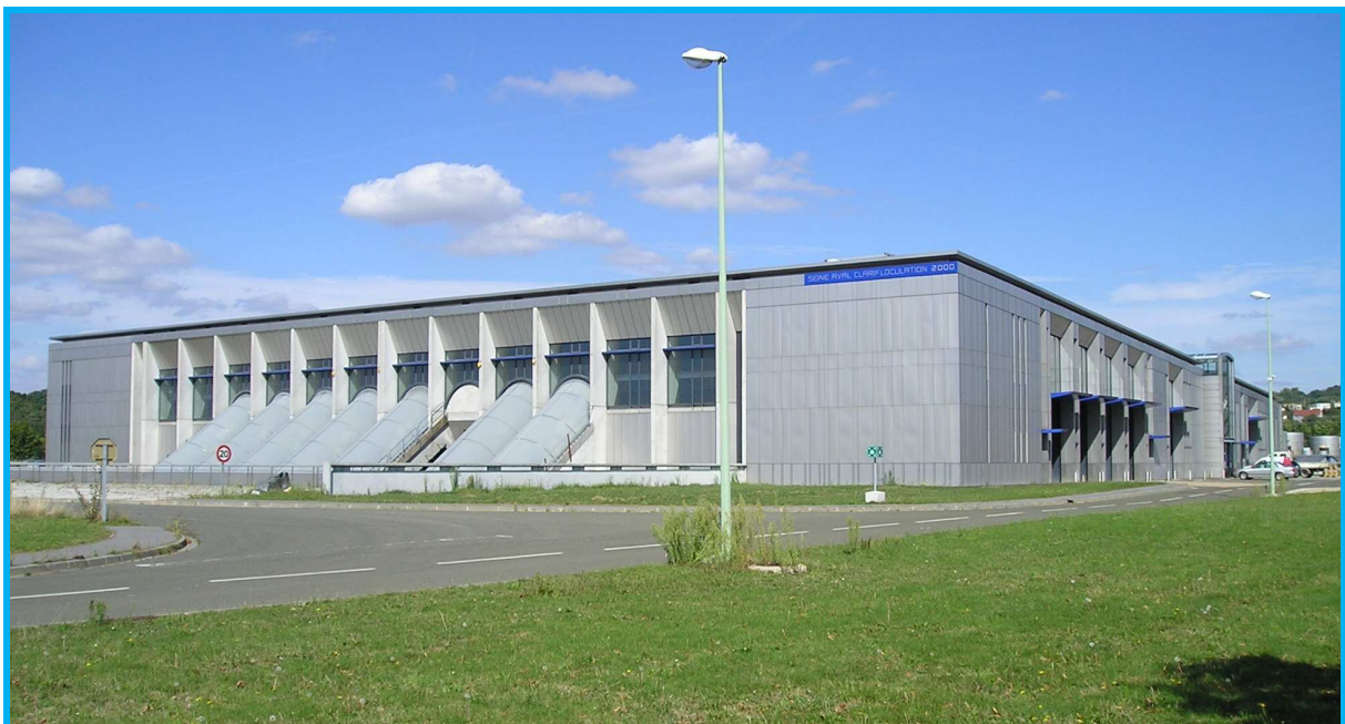
Figure 228 : Vue Sud du bâtiment de Clariflocculation
