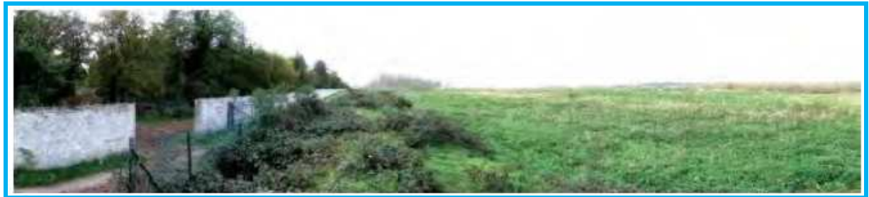
Figure 140 : Le mur en lisière de la forêt de St germain-en-Laye
