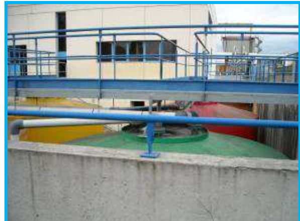
Figures 240 : Installation de traitement chimique de secours et ses cuves de réactifs (à droite)
