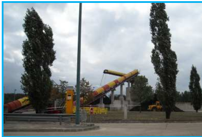
Figure 242 : Photo sur site des filtres-presses de la déshydratation des boues
